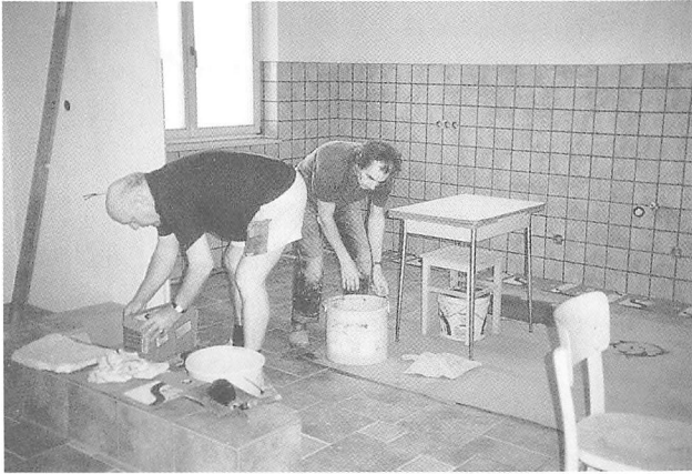
Die Fliesenleger beim Endsput
