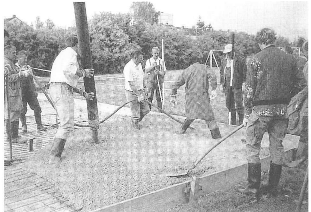
Viele fleißige Hände beim Betonieren der Bodenplatte
